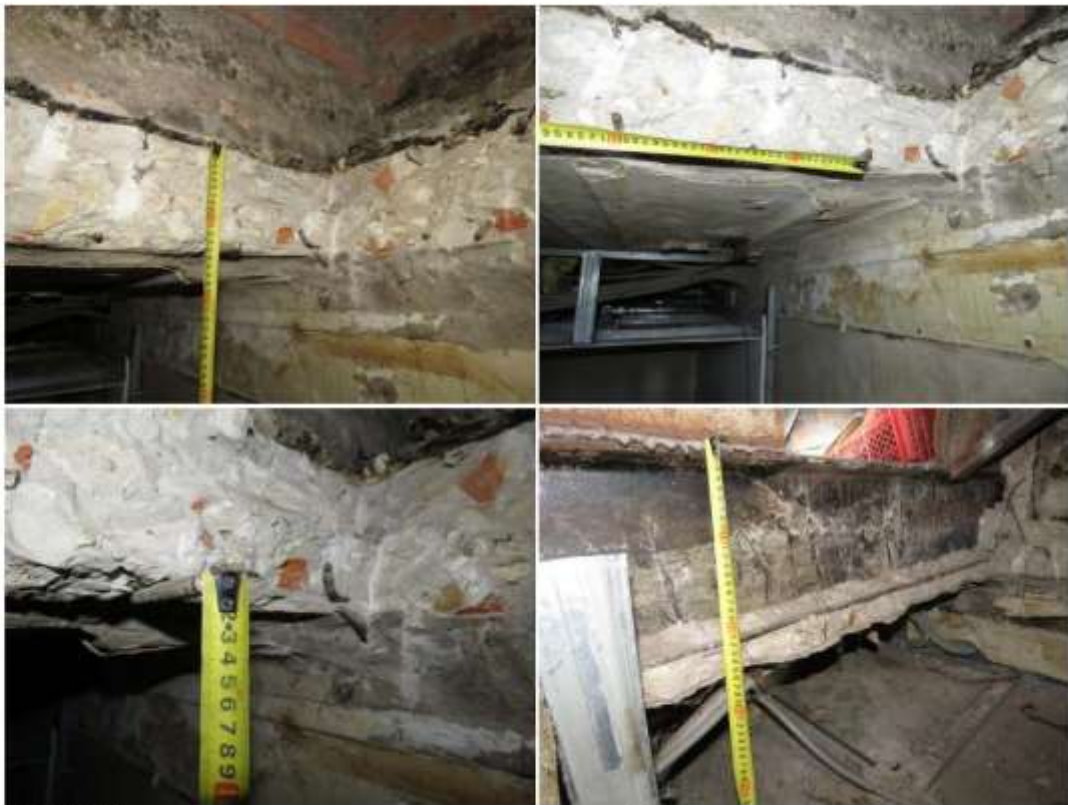
Фото 21-24. Измерение геометрических параметров балочного перекрытия (с элементами жесткого армирования).
