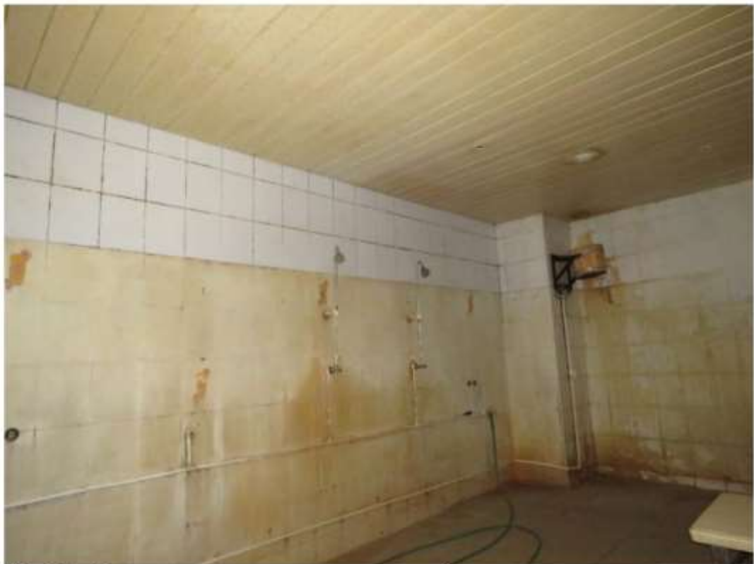
Фото 14. Общий вид и состояние отделки помещений здания.
