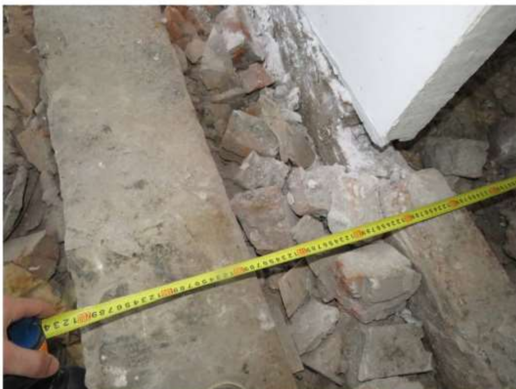
Фото 8. Измерение геометрических параметров балочного перекрытия.
