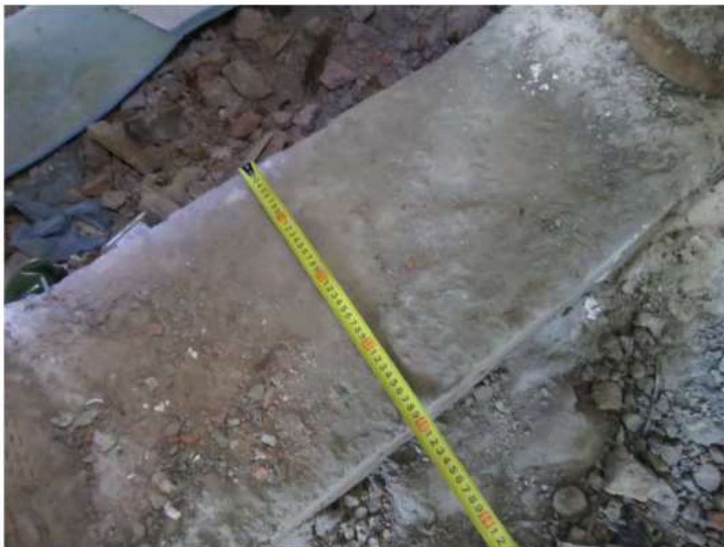
Фото 7. Измерение толщины внутренней несущей стены.
