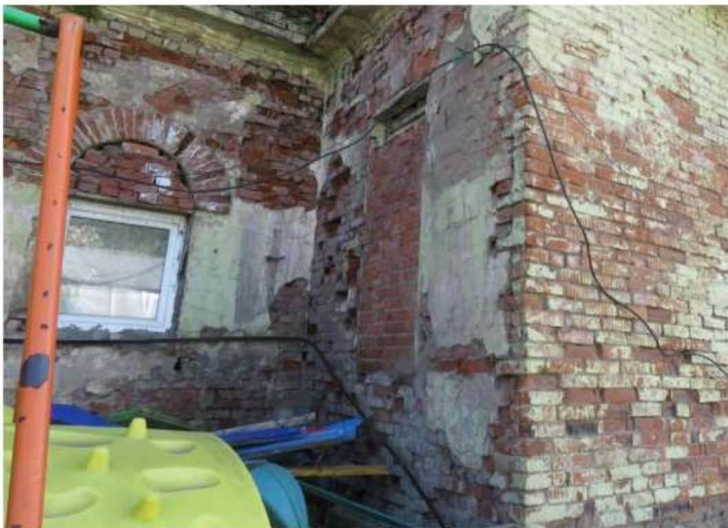
Фото 3. Общий вид и состояние наружных стен здания.
