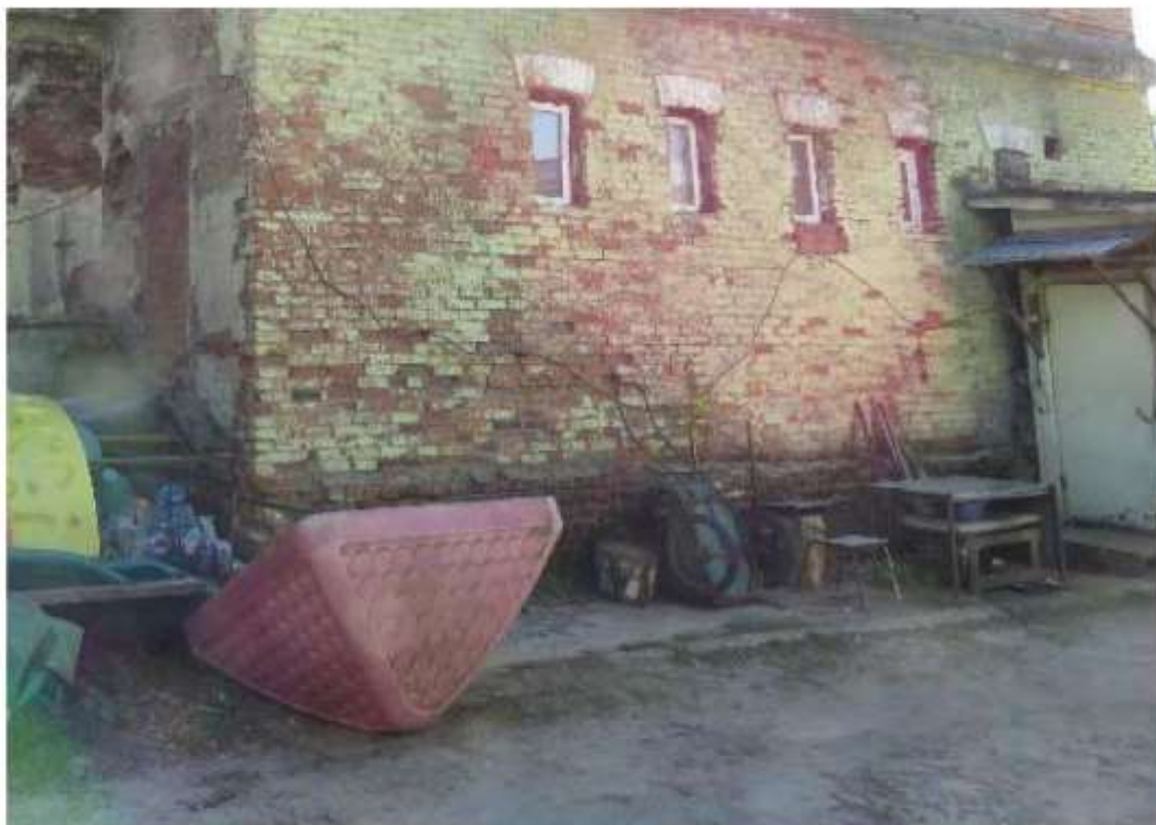
Фото 1. Фрагмент стены здания.
