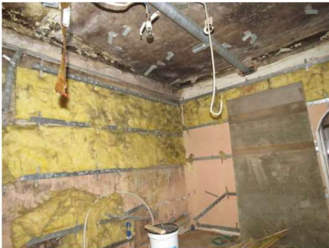
Фото 11. Общий вид и состояние отделки помещений здания.
